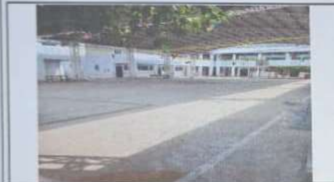
Foto 3: se hizo un relleno de 75 centímetros de alto con fundición debido a las inundaciones durante y después de la lluvia.
