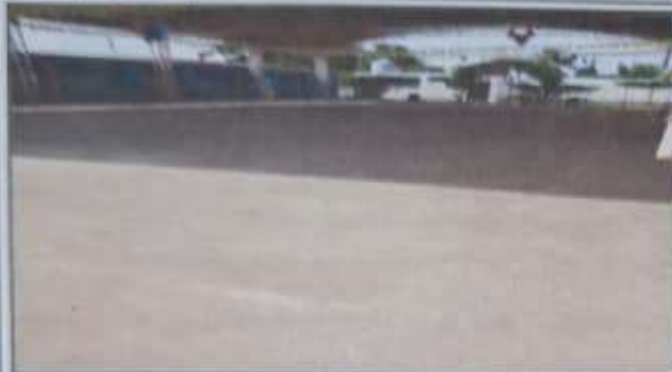
Foto 1: se hizo un relleno de 75 centímetros de alto con fundición debido a las inundaciones durante y después de la lluvia.
