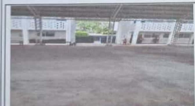
Foto 5: se hizo un relleno de 75 centímetros de alto con fundición debido a las inundaciones durante y después de la lluvia.
