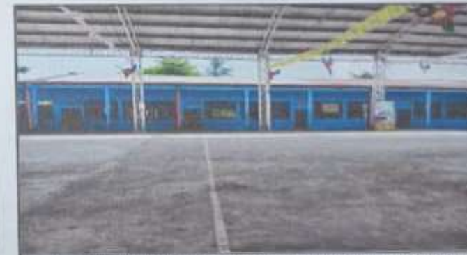
Foto 6: se hizo un relleno de 75 centímetros de alto con fundición debido a las inundaciones durante y después de la lluvia.
