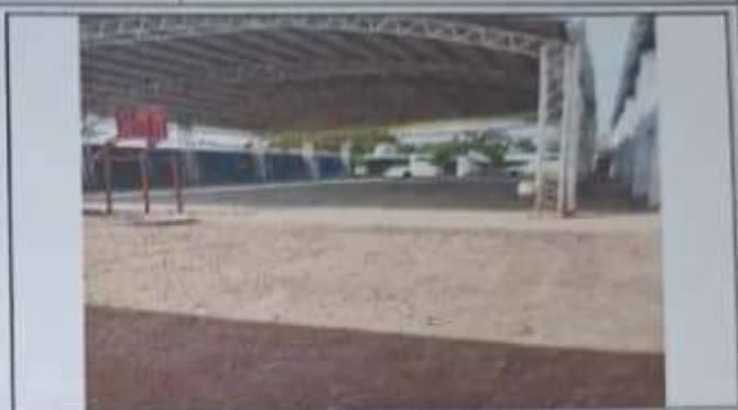
Foto 2: se hizo un relleno de 75 centímetros de alto con fundición debido a las inundaciones durante y después de la lluvia.
